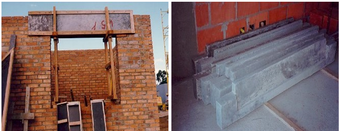
Figura 6. Minimização no número de passos na execução de alvenaria
